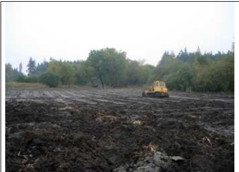
Odbahňování spodní nádrže
