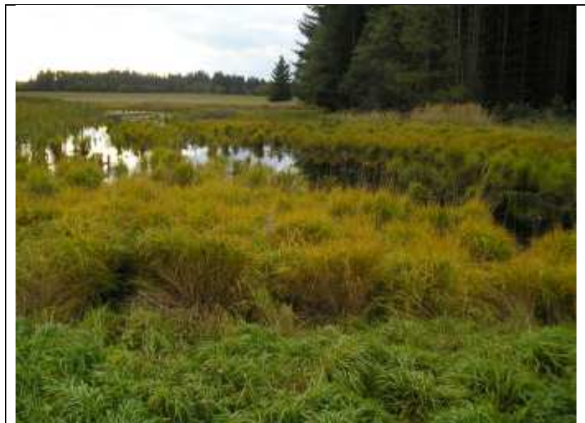
Zaplavené pobřeží prostřední nádrže po opravě její hrázy.
